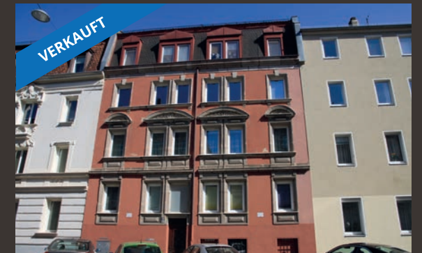
Mehrfamilienhaus mit 6 Wohnungen in Nürnberg-Wöhrd
