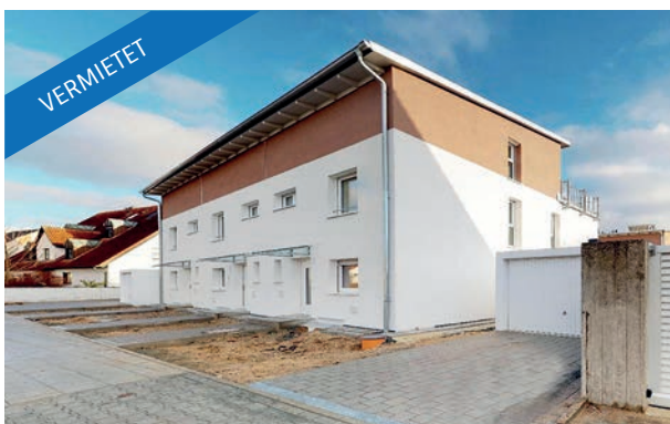
STADTHAUS IN MÖGELDORF 90480 Nürnberg
